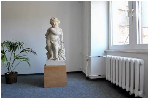
[2742] Die Wärmeverteilung mit den gusseisernen Radiatoren konnte beibehalten werden.
