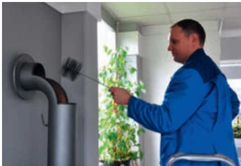
Kehren des Rauchrohrs
